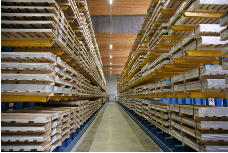
Bild 2: AMAG Logistikzentrum - Fertigwarenlager
