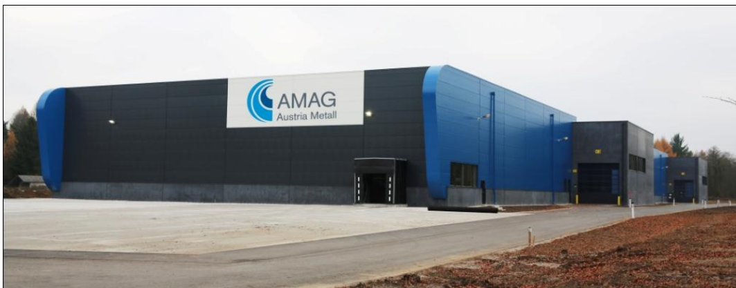
Bild1: AMAG Logistikzentrum Außenansicht
