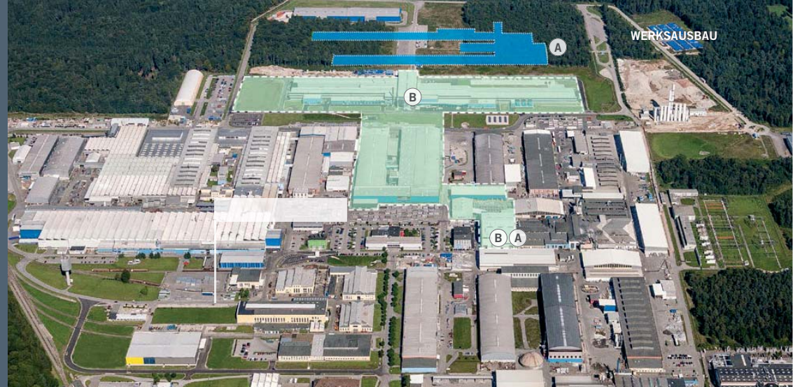
A Werksausbau „AMAG 2020“: Kaltwalzwerk, Banddurchzugssofen, Passivierungslinie, Gießerei
