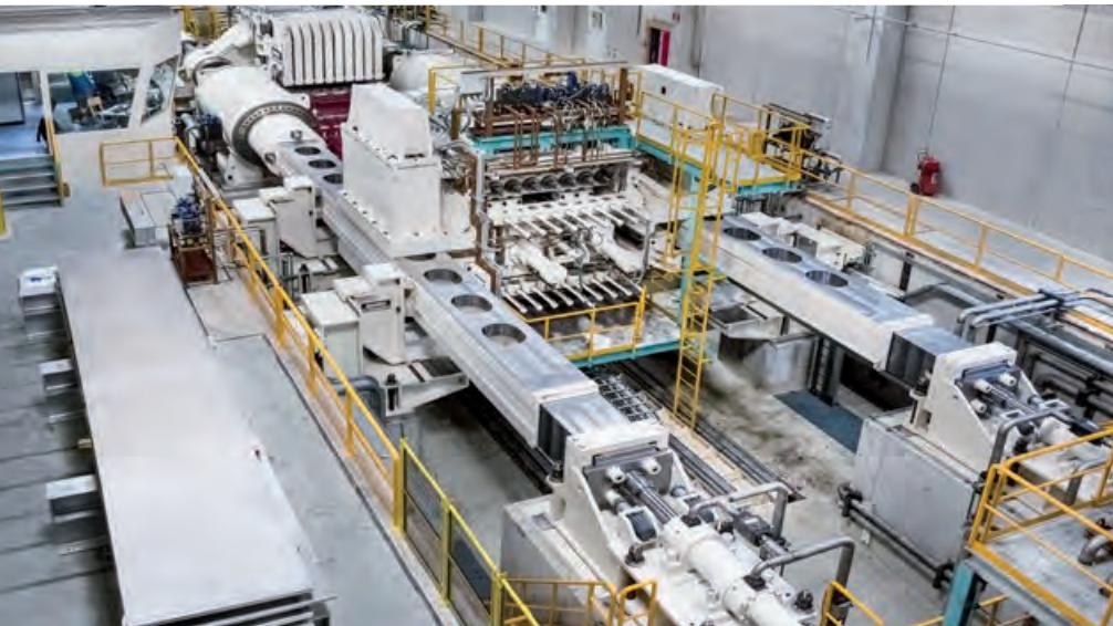
Neuer 80 MN Plattenrecker im Plattenfertigungscenter
