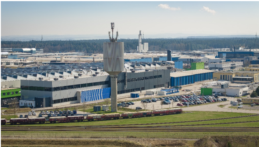
Bild 3: Die 115 Meter lange Anlage befindet sich in einem von regionalen Zulieferern errichteten Gebäude. (©AMAG)
